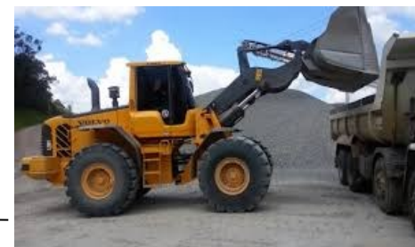
Carga do MDR9 - Pá carregadeira ou Retroescavadeira
